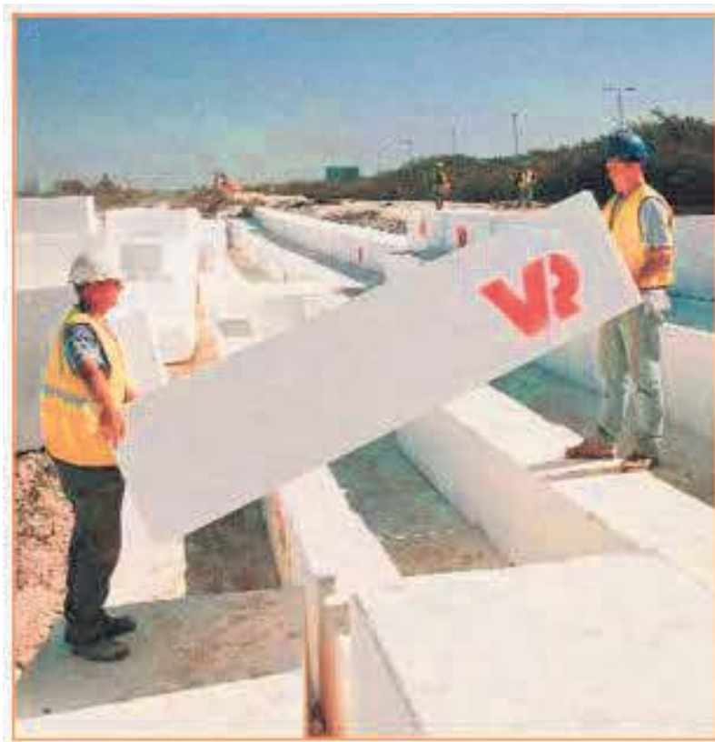
Kuva 20. Cippenhamissa M4 -tien yhteyteen tulevan meluvallin osa toteutettiin EPS -kevennyksellä. Valokuva kevennyksen rakentamisesta. (Jablite 2011).
