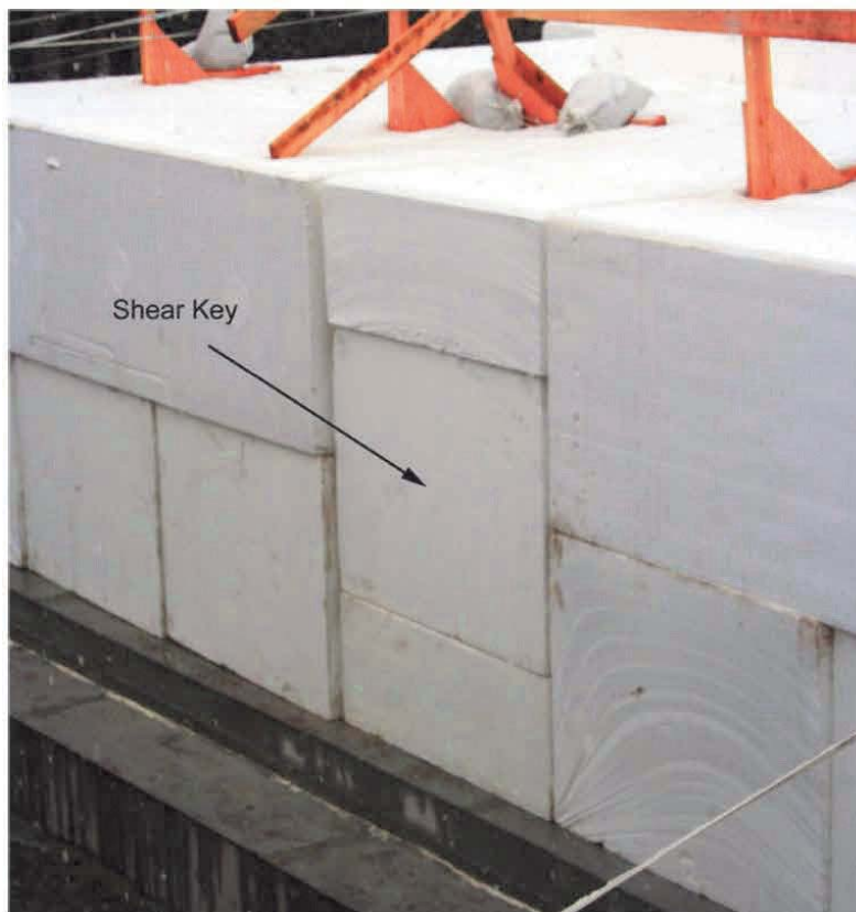
Kuva 34. Saumojen välistä vaakasuoraa leikkauslujuutta lisäävä sauman katkaiseva EPS-blokki (Bartlett et al. 2011, s.5).
