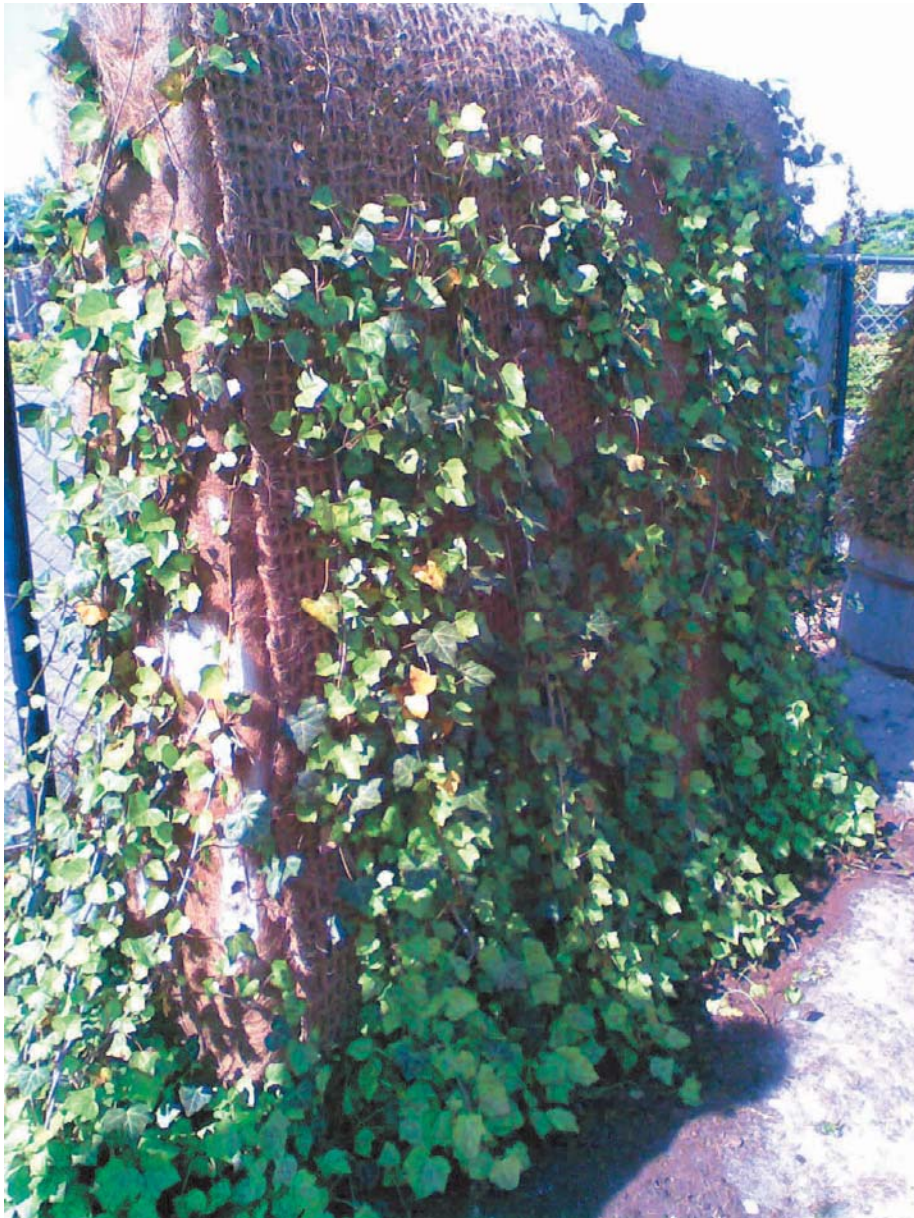
Kuva 21. EPS -meluseinä kookoskuitupeitteellä. (Tepper 2011).
