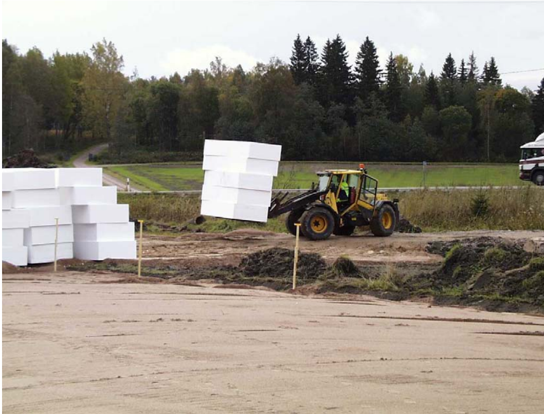
Kuva 10. EPS-harkkojen kuljetusta asennuspaikalle.
