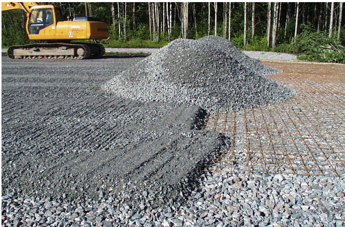
Kuva 14. Kantavan kerroksen materiaalin levitys teräsverkon päälle.
