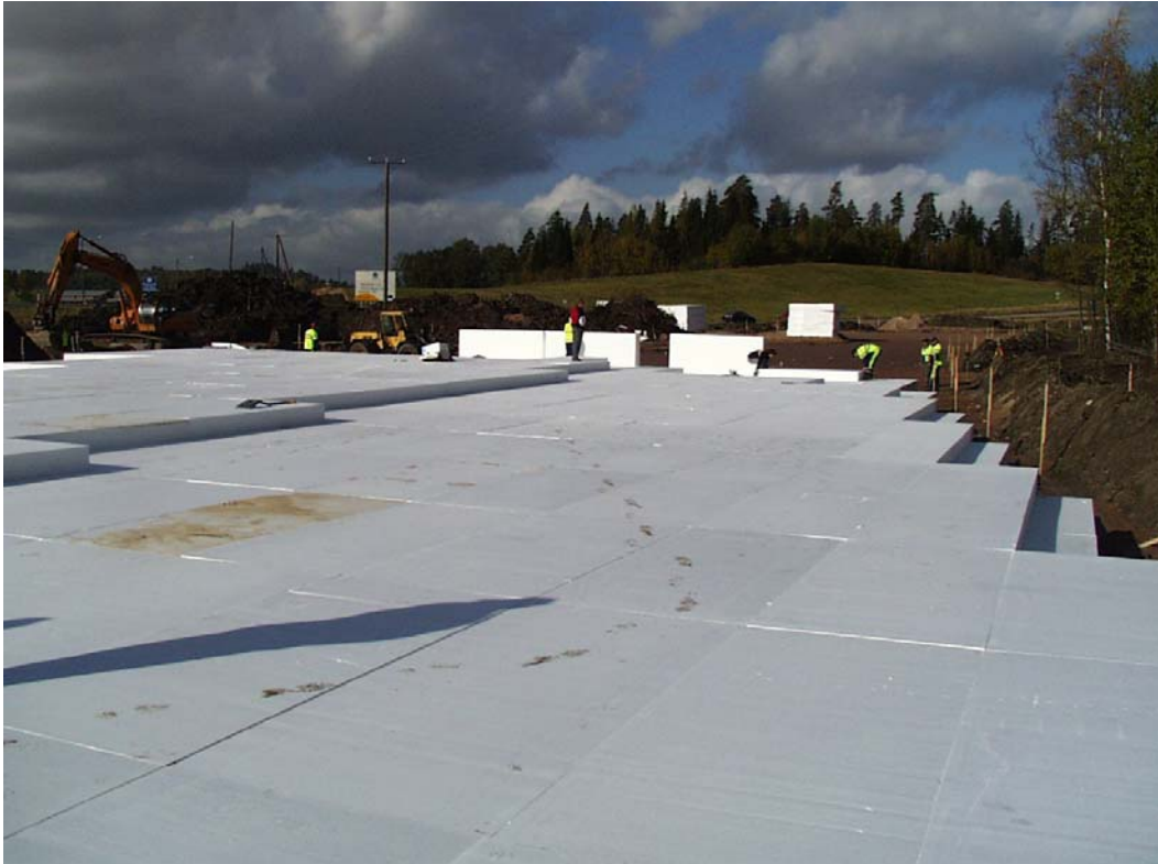
Kuva 8. Asennettujen EPS-harkkojen pintaa.
