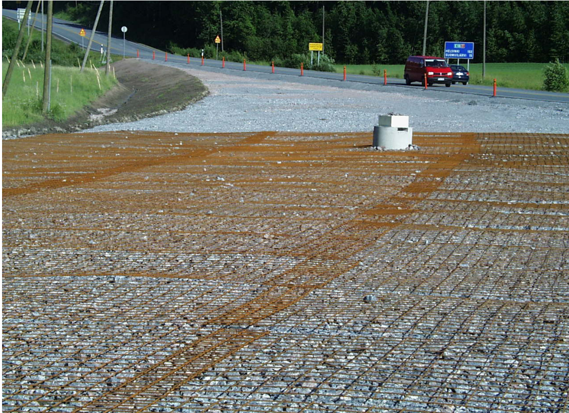
Kuva 13. Asennettuja teräsverkkoja.
