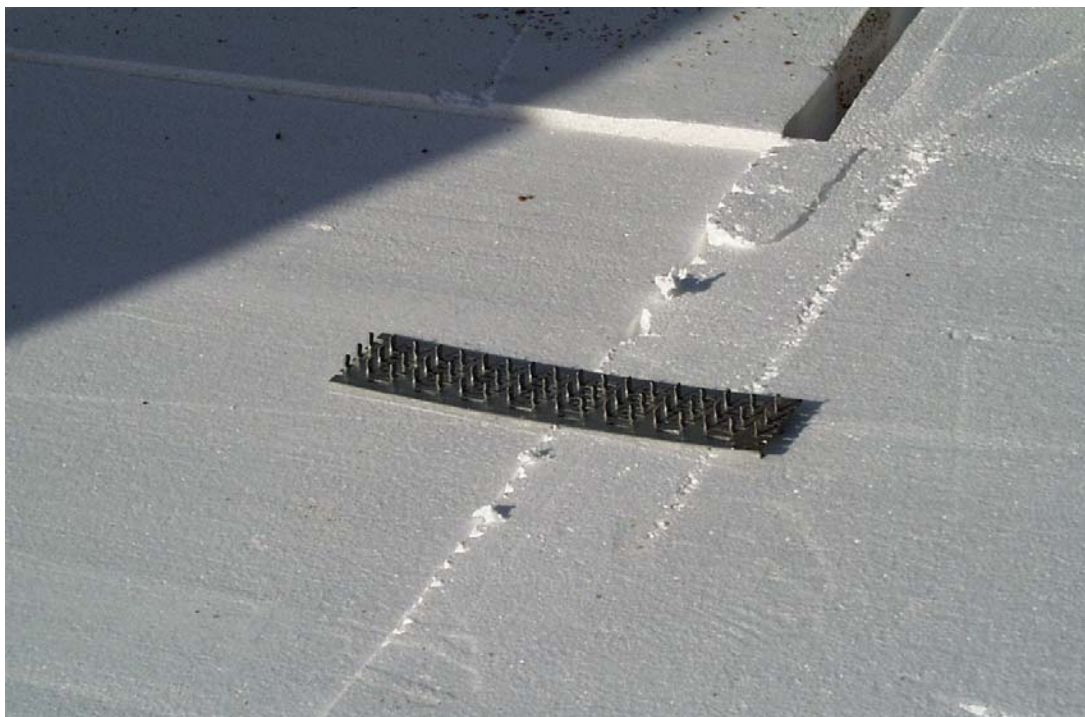
Kuva 7. EPS-harkkojen väliin sijoitettu naulalevy-tyyppinen liitoskappale.
