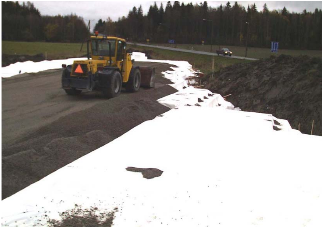
Kuva 12. Suojakerroksen levitystä.
