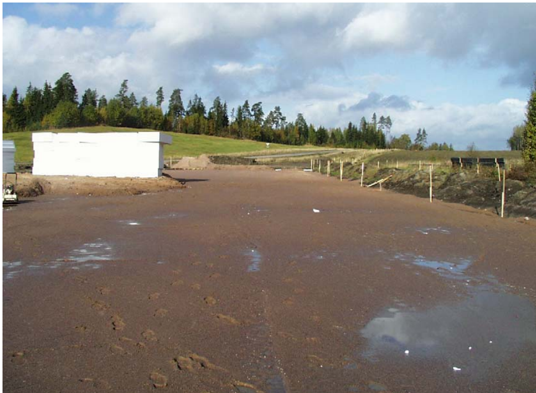
Kuva 5. Alueen yleiskuva tasaushiekkakerroksen levittämisen jälkeen.
