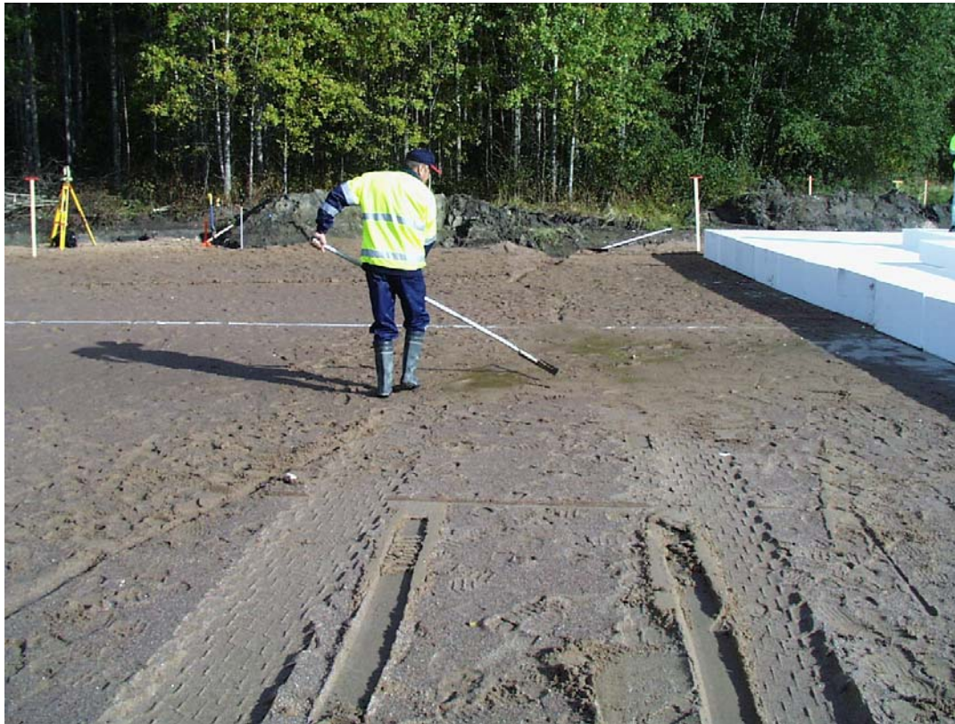
Kuva 6. Hiekkakerroksen tasausta EPS-harkkojen edessä.
