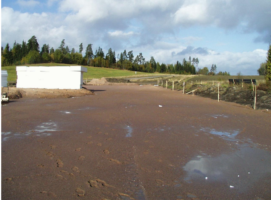
Kuva 6.6 Alueen yleiskuva tasaushiekkakerroksen levittämisen jälkeen (kuva: L Korkiala-Tanttu).
