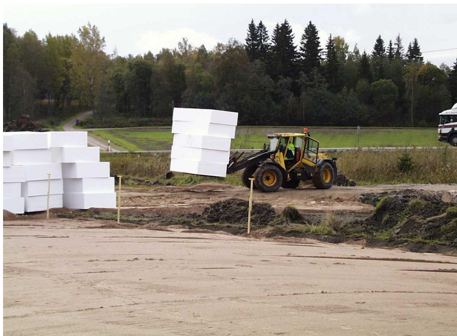
Kuva 6.11 EPS-blokkien kuljetusta asennuspaikalle (kuva: L Korkiala-Tanttu).
