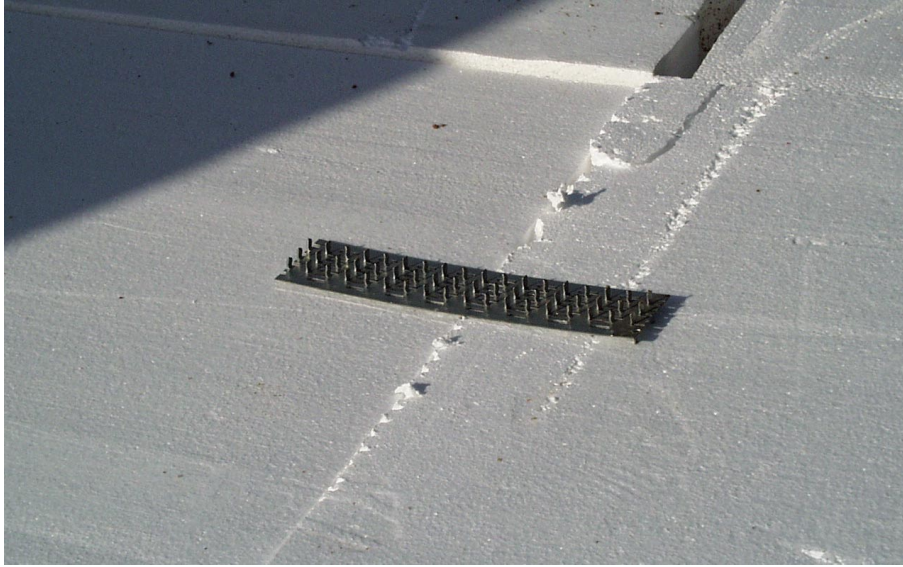
Kuva 6.8 EPS-blokien väliin sijoitettu naulalevy-tyyppinen liitoskappale (kuva: L Korkiala-Tanttu).
