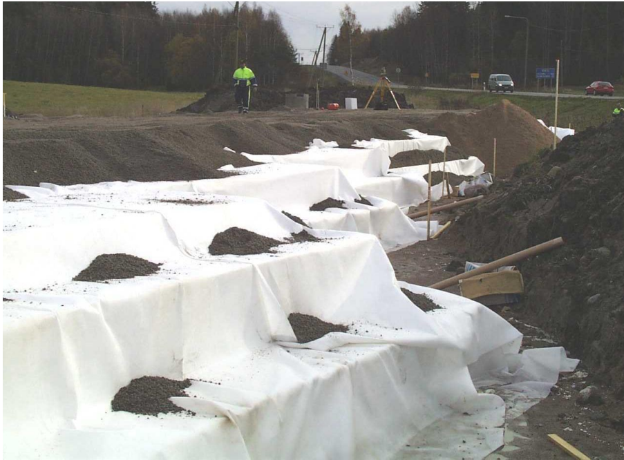
Kuva 6.12 Blokien suojausrakenteet (kuva: L Korkiala-Tanttu).
