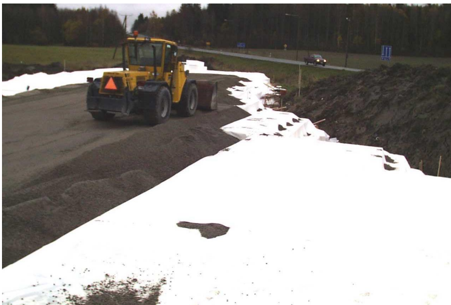
Kuva 6.13 Suojakerroksen levitystä (kuva: L Korkiala-Tanttu).
