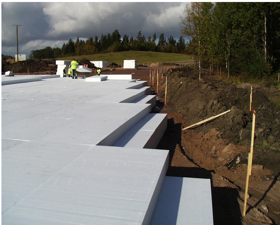
Kuva 6.1 Muurlan koerakenne. EPS-kevennetäytön yleiskuva (kuva: L Korkiala-Tanttu).
