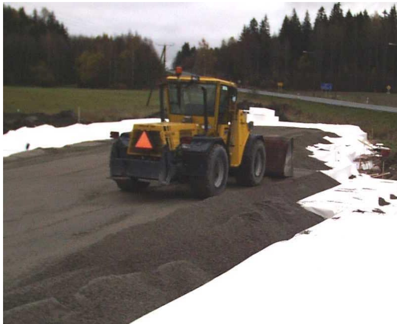
Kuva 5.5 Kalvon päälle levitetään geotekstiili. Geotekstiilin päälle levitetään tasauskerros murskeesta, paksuudeltaan vähintään 200 mm. Murskeen suurin raekoko saa olla enintään #64 mm (kuva: L Korkiala-Tanttu).
