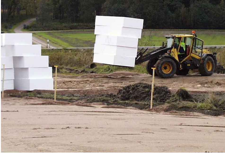
Kuva 5.2 EPS-blokit kuljetetaan asennuspaikalle kuorma-autosta tai varastosta esimerkiksi etukuormaajalla (kuva: L Korkiala-Tanttu).
