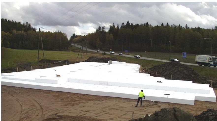
Kuva 5.3 . EPS-blokit asennetaan suunnitelman mukaisen sijoittelukaavion osoittamille paikoille käsityönä. Päällekkäisten EPS-blokien väliin asetetaan esim. Naulalevysiteet (kuva: L Korkiala-Tanttu).
