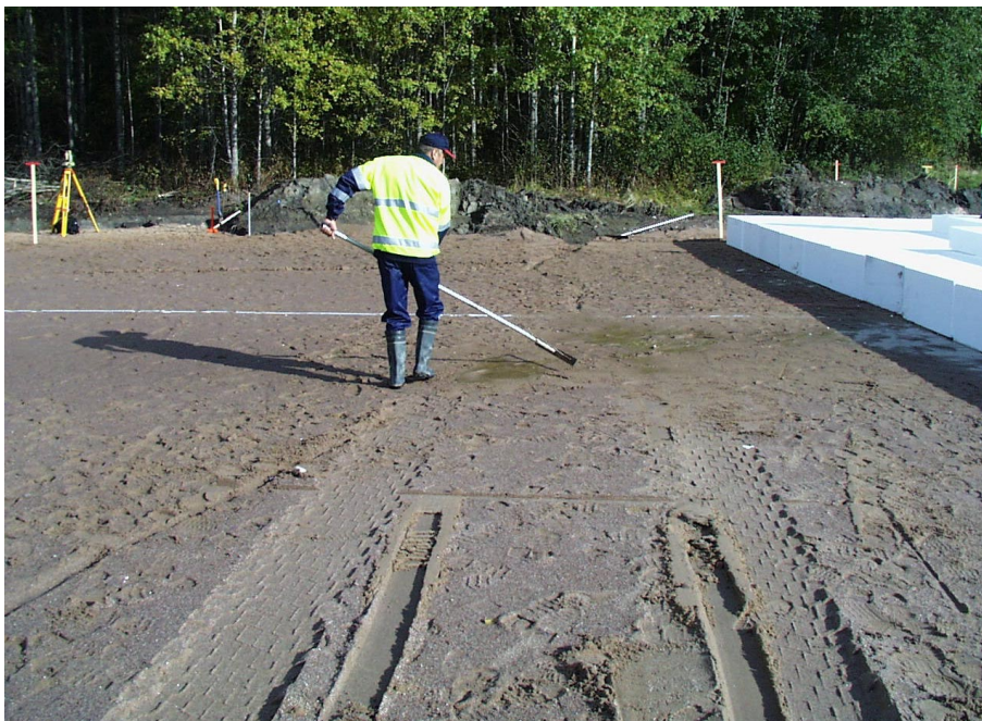
Kuva 6.7 Hiekkakerroksen tasausta EPS-blokien edessä (kuva: L Korkiala-Tanttu).
