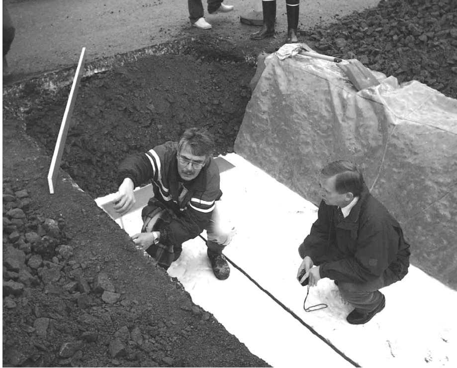
Kuva 16.6b Esiin kaivettu EPS-pinta koekuopassa Pesurinkadulla (kuva H Kangas).
