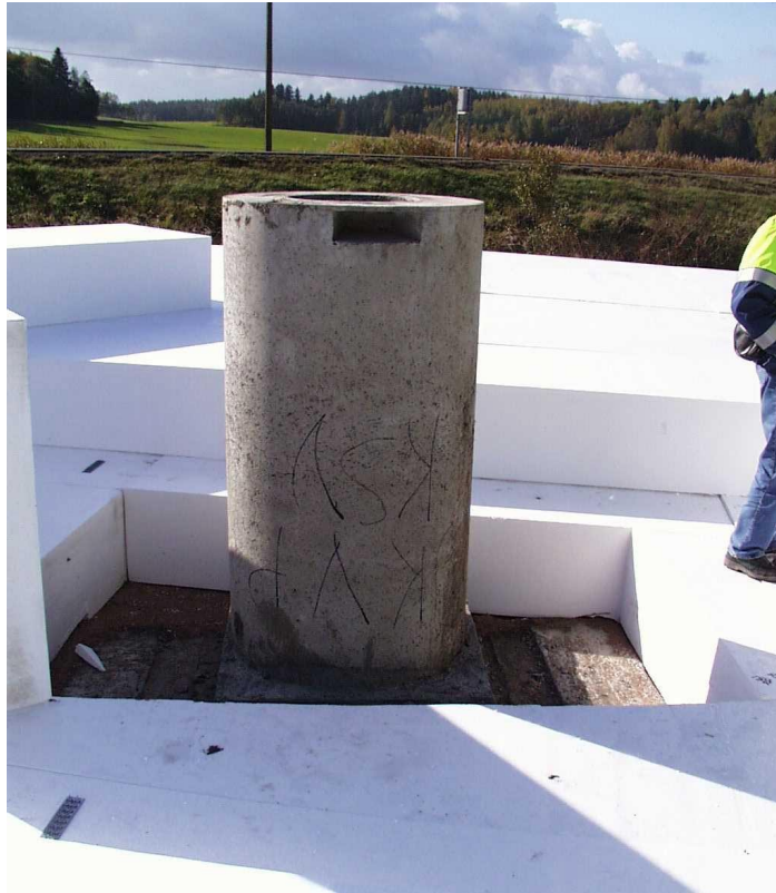
Kuva 6.10 Portaali-perustuksen ympäristö (kuva: L Korkiala-Tanttu).
